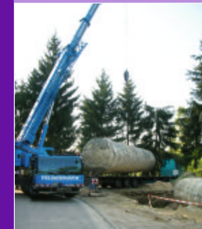
Baustart für die Öko-Heizung: Die alten Öltanks werden entfernt.
